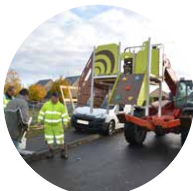
Montage de la structure de jeu - novembre
