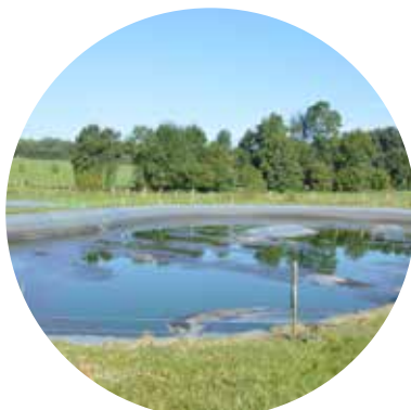
Travaux lagune des Cartes septembre
